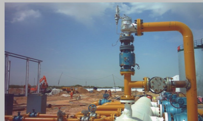
罗阀在塔输管道工程现场
