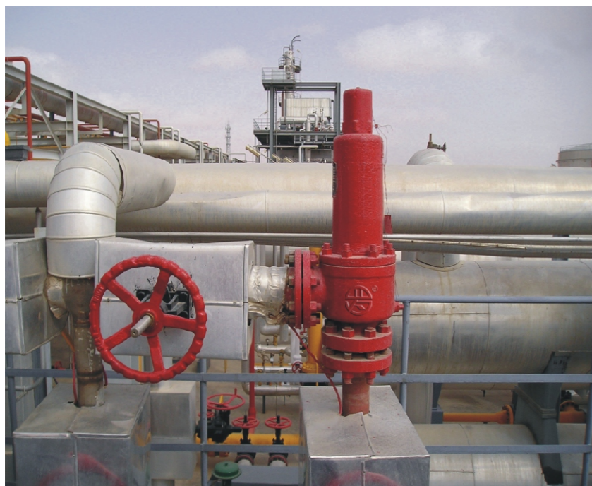
罗阀在塔里木油田牙哈作业区现场
